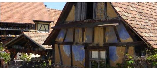
Le torchis mérite d'être conservé pour son authenticité et ses performances thermiques. Les enduits doivent être lisses ou à faible relief. L'enduit est traditionnellement un enduit minéral à la chaux, au même nu que le colombage, sans débord. En cas de rénovation de la façade, si l'on conserve le remplissage du colombage existant et que l'enduit vient en surépaisseur, le débord devra être aplati au maximum sur les angles pour ne pas former d'angle saillant et d'arêtes rectilignes.
